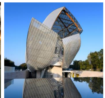
Le centre d'art contemporain de la Fondation Louis Vuitton : la conception architecturale, avec son ossature, ses verrières, son enveloppe opaque dénommée "iceberg" et ses enveloppes vitrées. Le clos couvert du bâtiment est assuré par les façades vitrées et les enveloppes opaque de l'Iceberg, revêtu de Ductal (panneaux en Béton Fibré à Ultra-haute Performance). TESS et © Louis-Marie Dauzat
