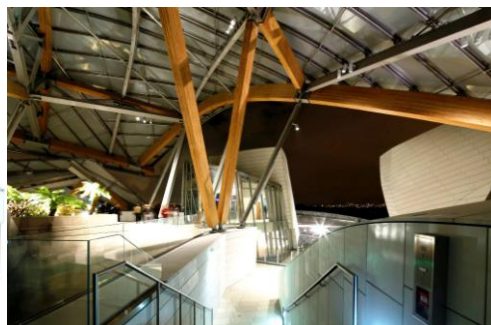
Le centre d'art contemporain de la Fondation Louis Vuitton : la conception architecturale, avec son ossature, ses verrières, son enveloppe opaque dénommée "iceberg" et ses enveloppes vitrées. Le clos couvert du bâtiment est assuré par les façades vitrées et les enveloppes opaque de l'Iceberg, revêtu de Ductal (panneaux en Béton Fibré à Ultra-haute Performance). TESS et © Louis-Marie Dauzat
