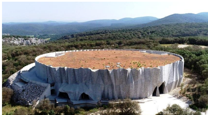
Site du Razal à Vallon-Pont-d'Arc : l'espace de restitution, avec la réplique de la cavité originale.
